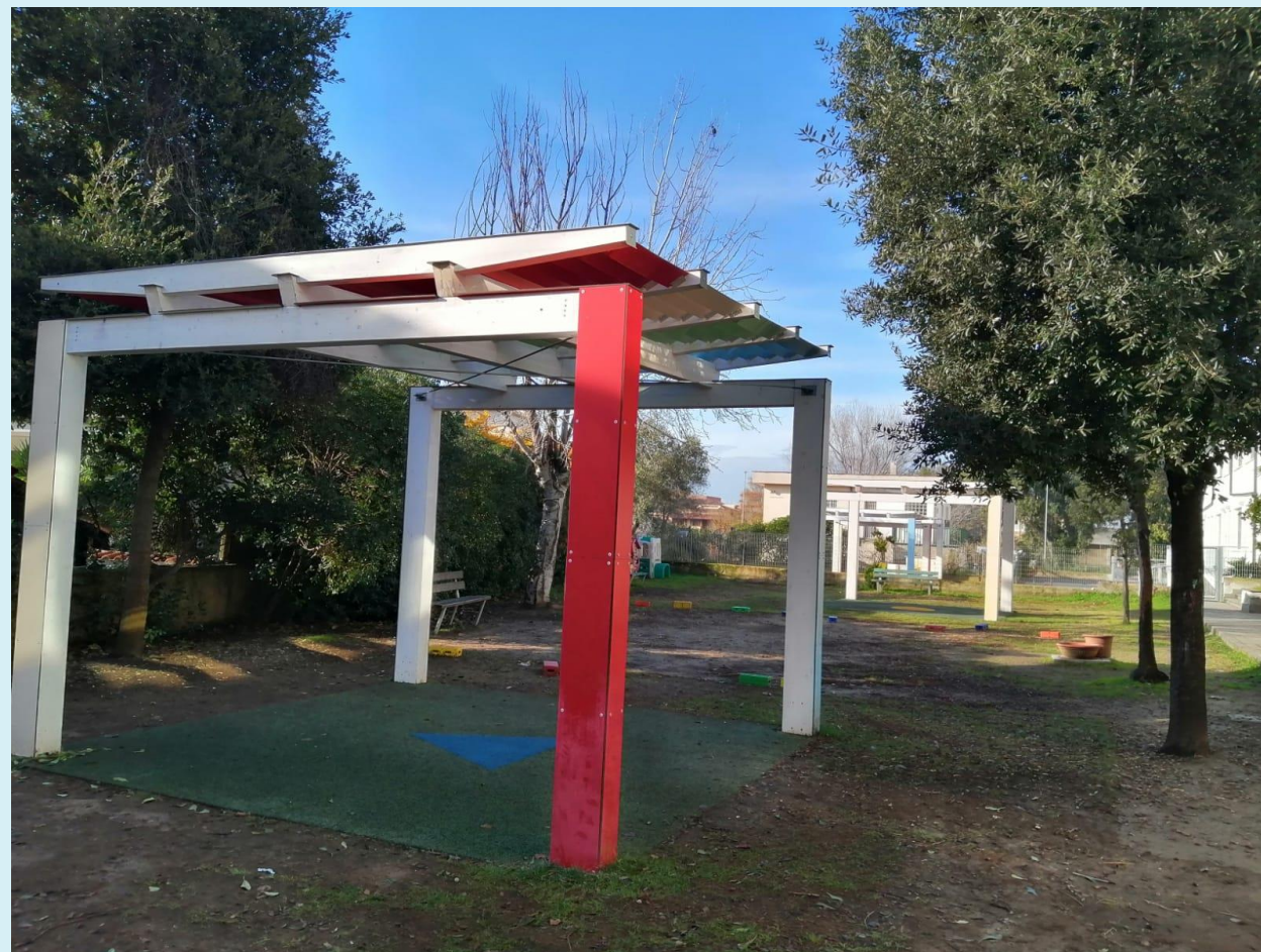
Giardino del Corbezzolo
